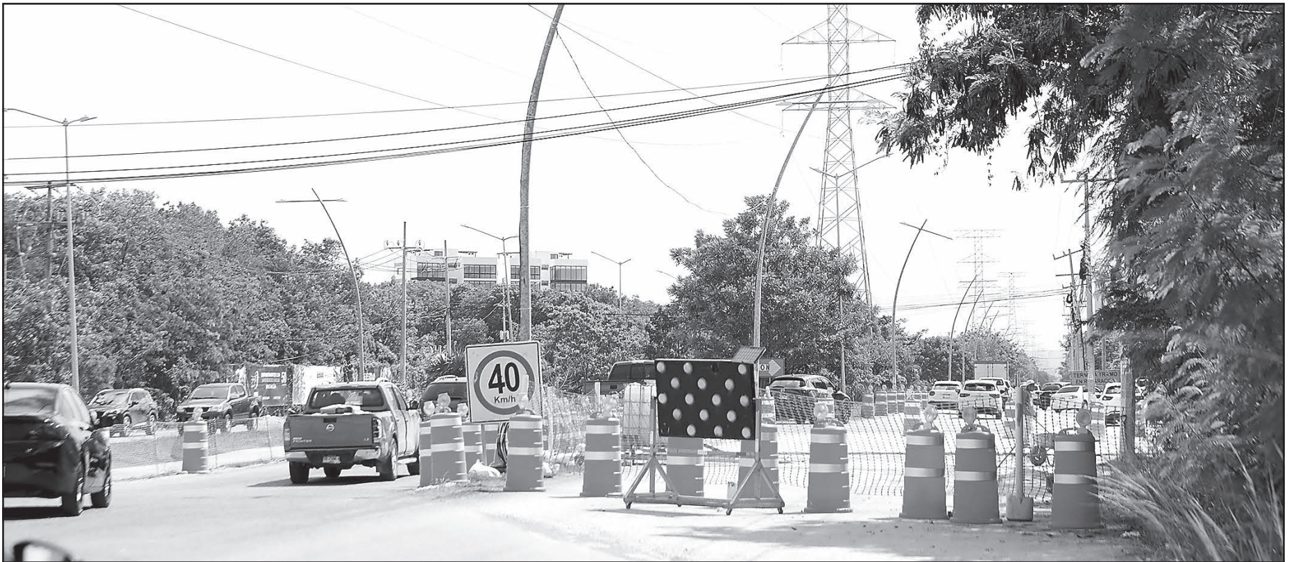
En las avenidas Huayacán y Colegios de Benito Juárez, una gran cantidad de habitantes se quejan por el pésimo bombeo de Aguakan y los recibos caros. (Fotos R. Flores)
