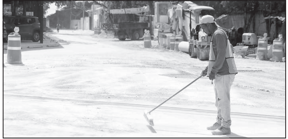
La lentitud de las obras en las calles Olivo y Colegios empiezan a generar molestia.
