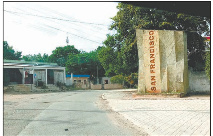
El inmueble funcionará como base permanente de vigilancia. (Fotos E. Cauch)
