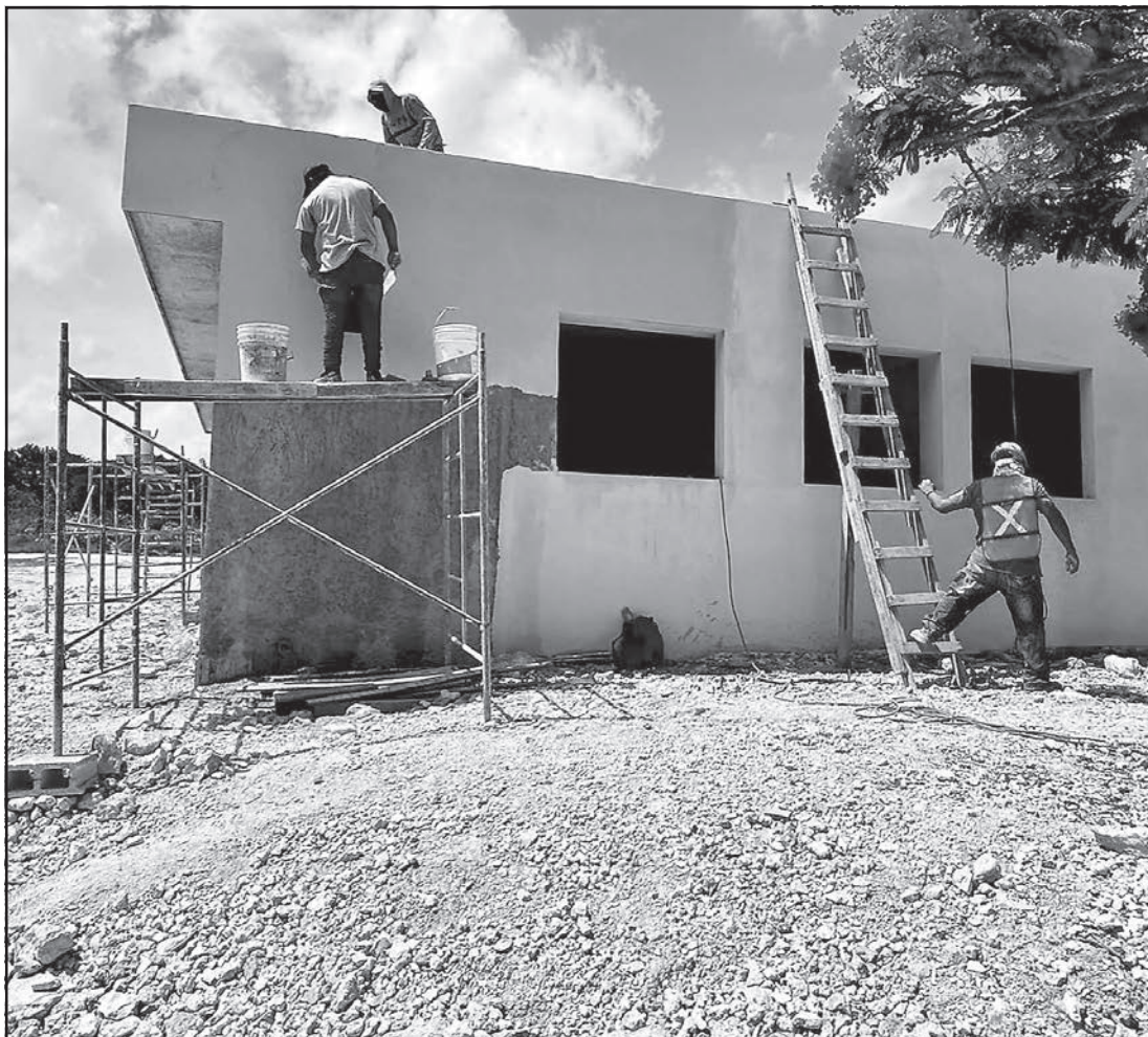
Los encargados de la construcción destacaron que buscan cumplir con los tiempos establecidos. (Fotos Liza Vera)
