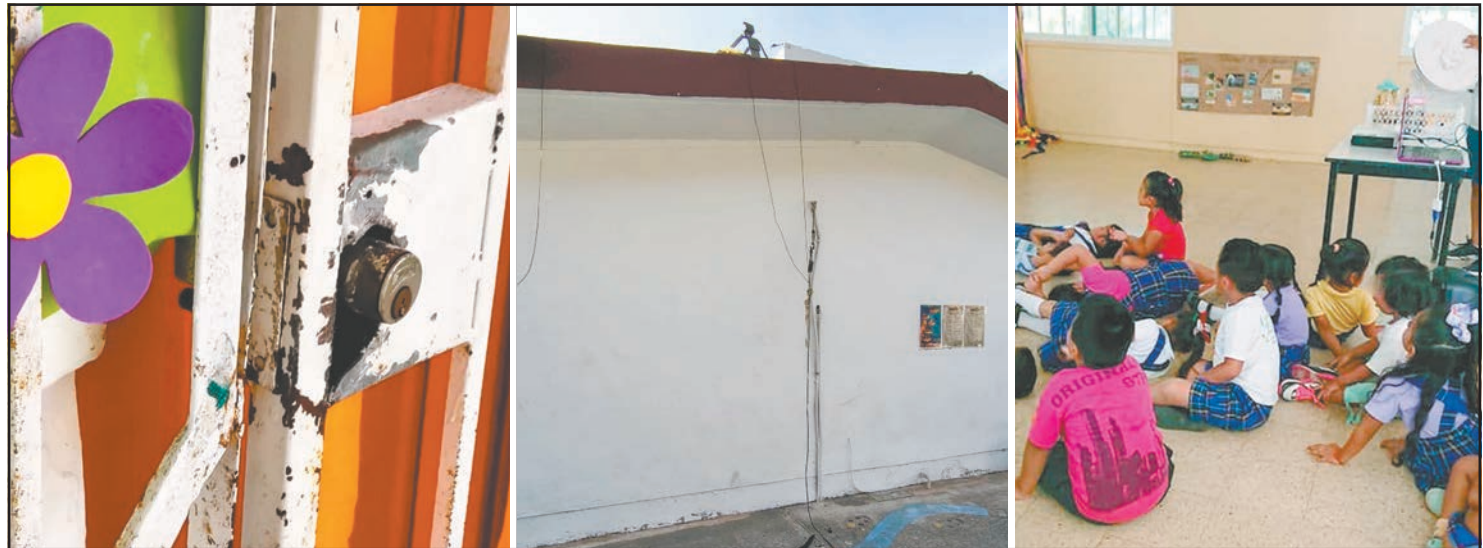
Ladrones se llevaron cableado eléctrico y un compresor de aire acondicionado, situación que impacta a los alumnos. (Fotos Antonio Blanco)
