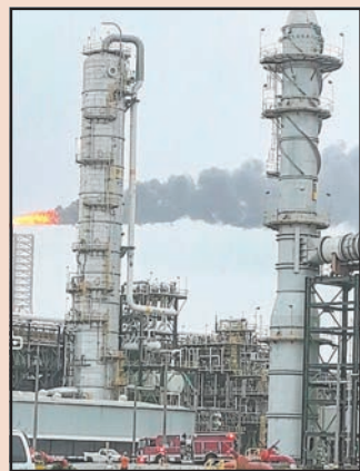
En la refinería se detectó una falla eléctrica, según reportes.
