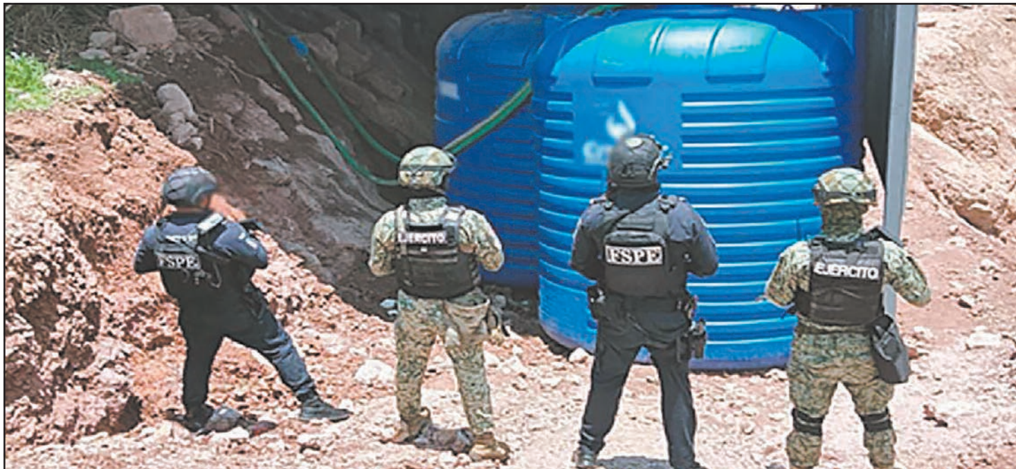
En el sitio fue hallada una cisterna con capacidad para almacenar 50 mil litros de hidrocarburo, pero se encontraba al 10%. (POR ESTO!)
