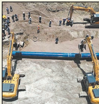
El acueducto está en reparación.
