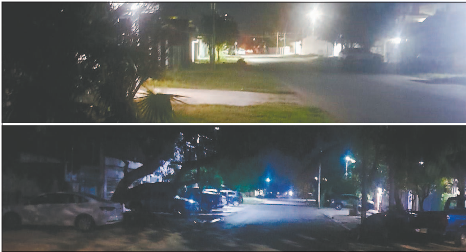
Habitantes refirieron que algunas luminarias están inservibles y otras operan intermitentemente; ninguna ha recibido mantenimiento. (Fotos POR ESTO!)
