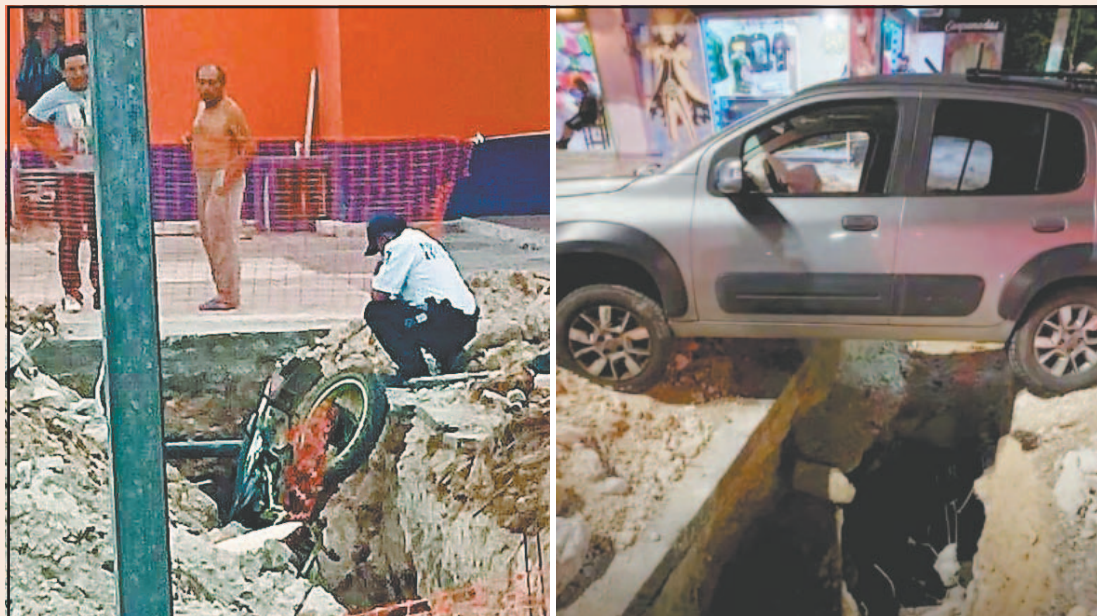
Quejosos dijeron que la construcción inició hace cuatro meses y no hay avances. (Fotos POR ESTO!)
