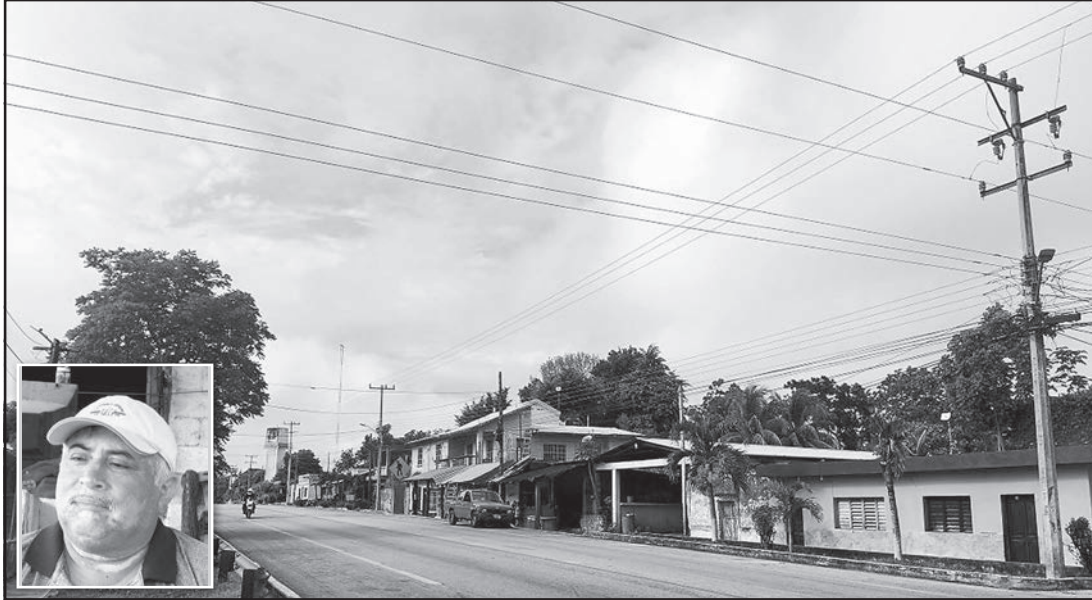
Eliodoro Mex aseguró que urge la sustitución de líneas de distribución y transformadores. (Fotos L. Kauil)
