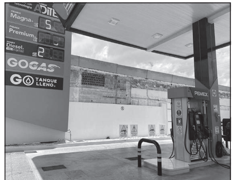
La estación con el precio elevado está en avenida Talleres. (R. Flores)
