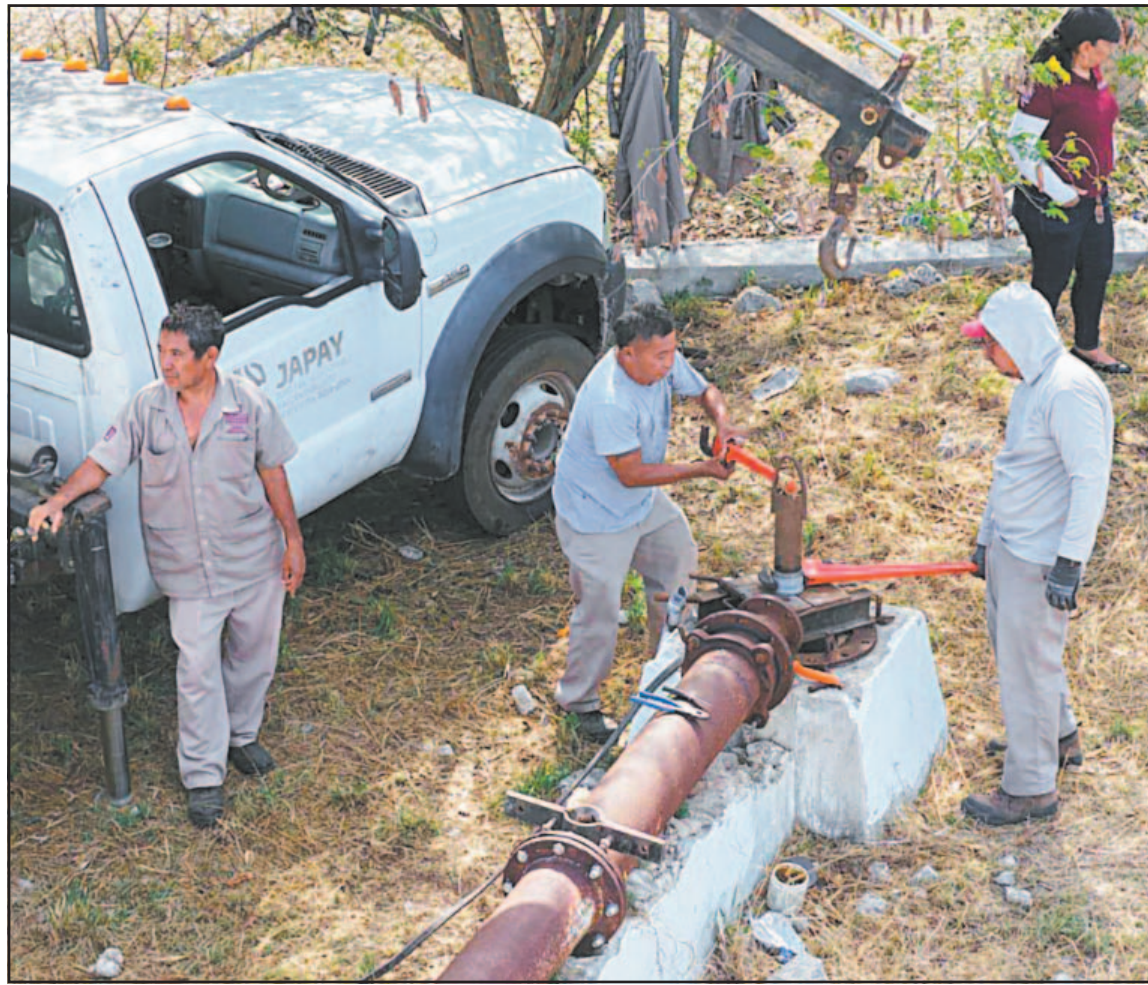
Las obras permitirán aumentar la capacidad de saneamiento, con estándares de calidad. (POR ESTO!)
