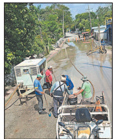
Trabajaron en zonas afectadas.
