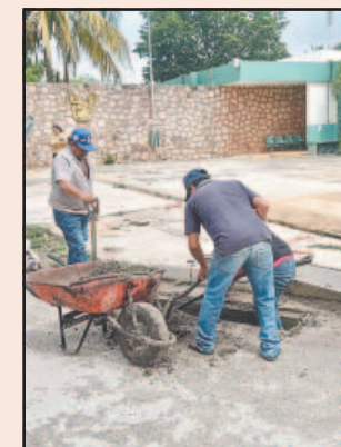
Extrajeron sedimentos de las alcantarillas. (E. Chan)
