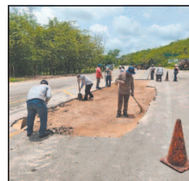
Mantienen labores de reparación.
