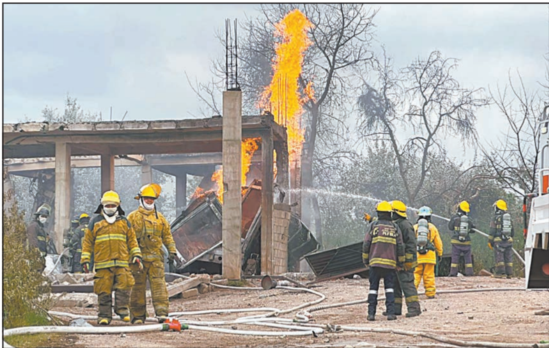
Del depósito ilegal de gas LP sólo quedaron en pie algunos castillos de concreto con las varillas expuestas.
