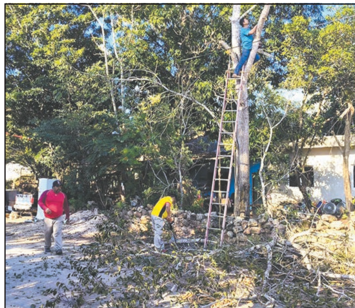
Dijeron que afecta la vegetación que se extiende hasta la vía pública. (L. Kauil)
