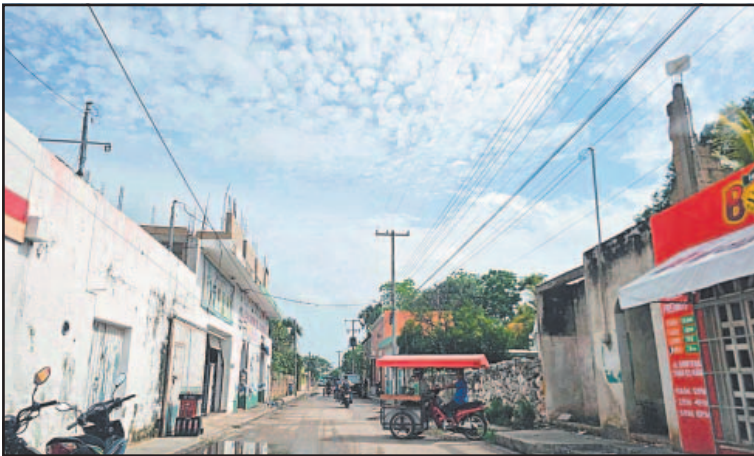
La carretera principal es de las más afectadas por el intenso tráfico.
