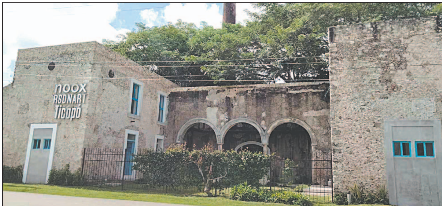
El cuarto de máquinas de la época del porfiriato fue remodelado y recibe a visitantes foráneos y locales en su nueva etapa turística.
