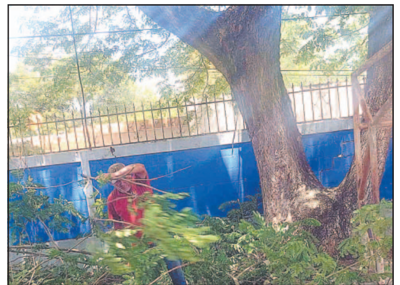
Personal de Aseo Urbano cortó las ramas que rozaban las líneas.
