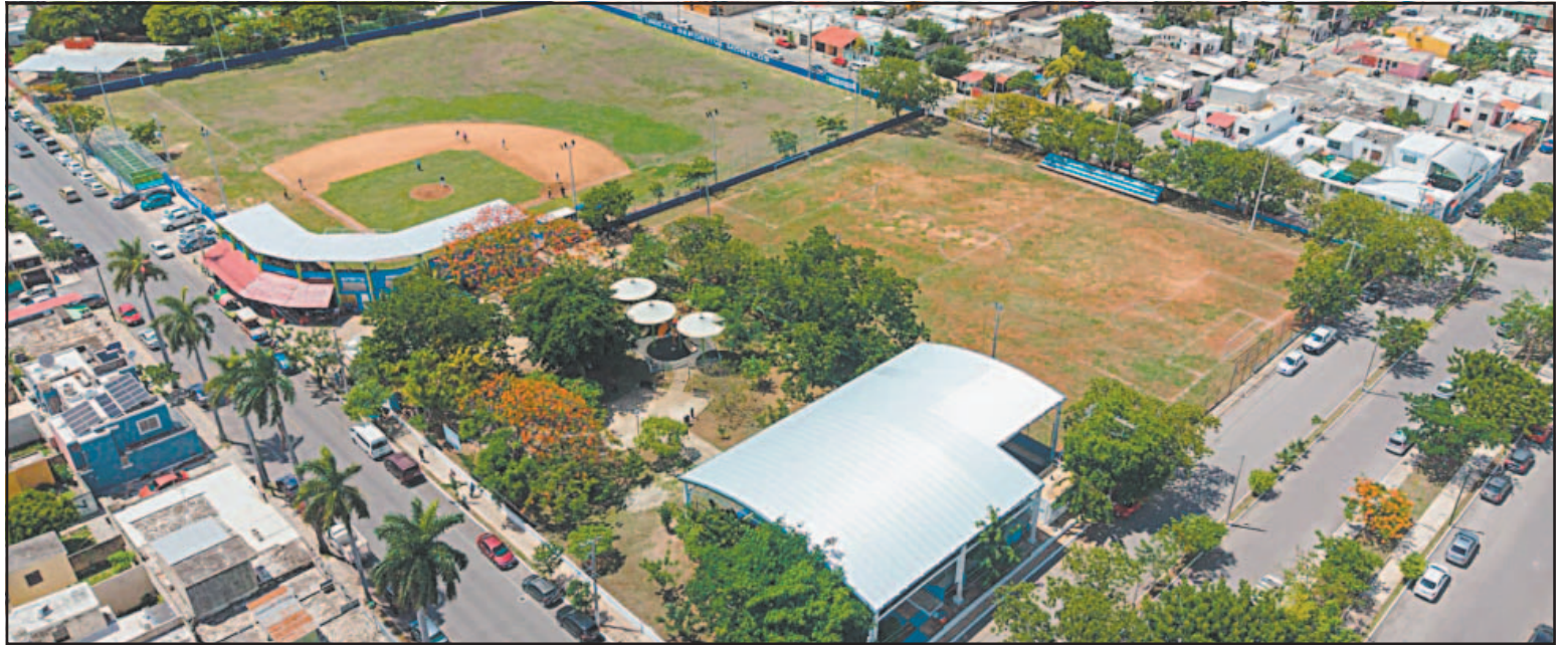
La alcaldesa Cecilia Patrón entregó a los vecinos las obras en el espacio recreativo; diversas familias acudieron al evento. (POR ESTO!)
