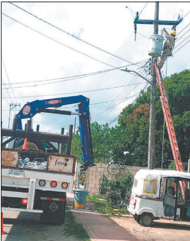
Inconformes señalaron que las fallas son recurrentes. (Enrique Cauich)
