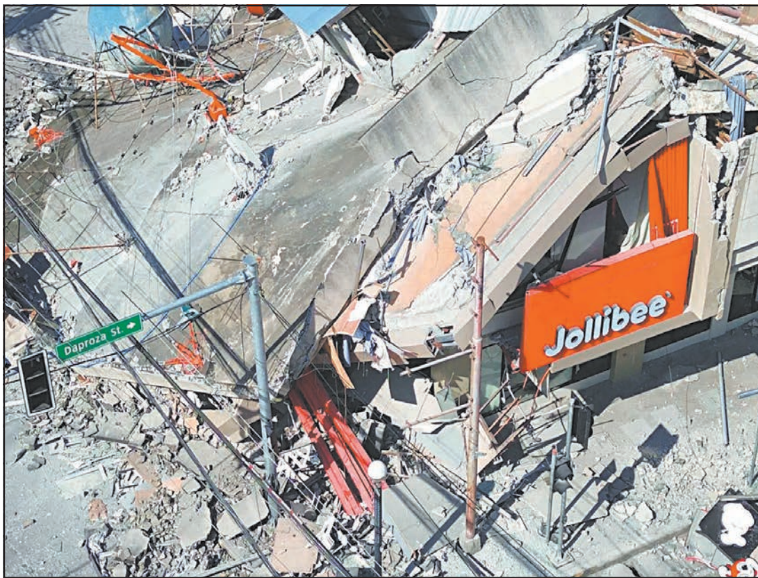
Vista captada con un dron del derrumbe de un comercio en General Santos, Mindanao. (Agencias)
