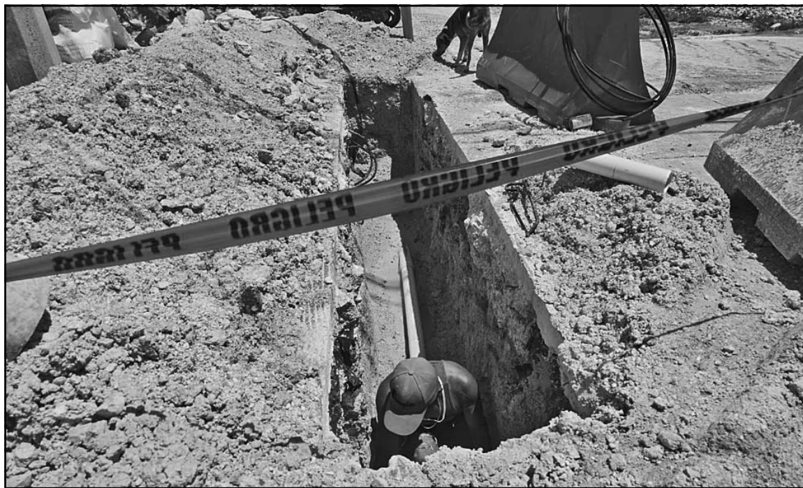
Abrieron nuevamente el pavimento para atender las fallas registradas en la infraestructura hidráulica.
