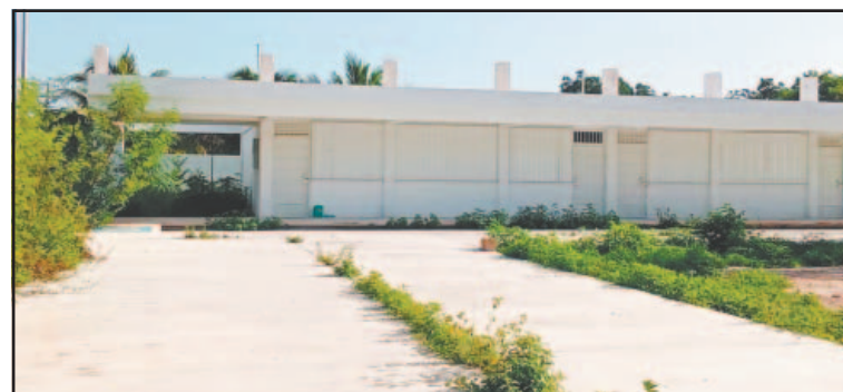
El plantel cuenta con aulas equipadas, luz y aire acondicionado. (E. Cauch)
