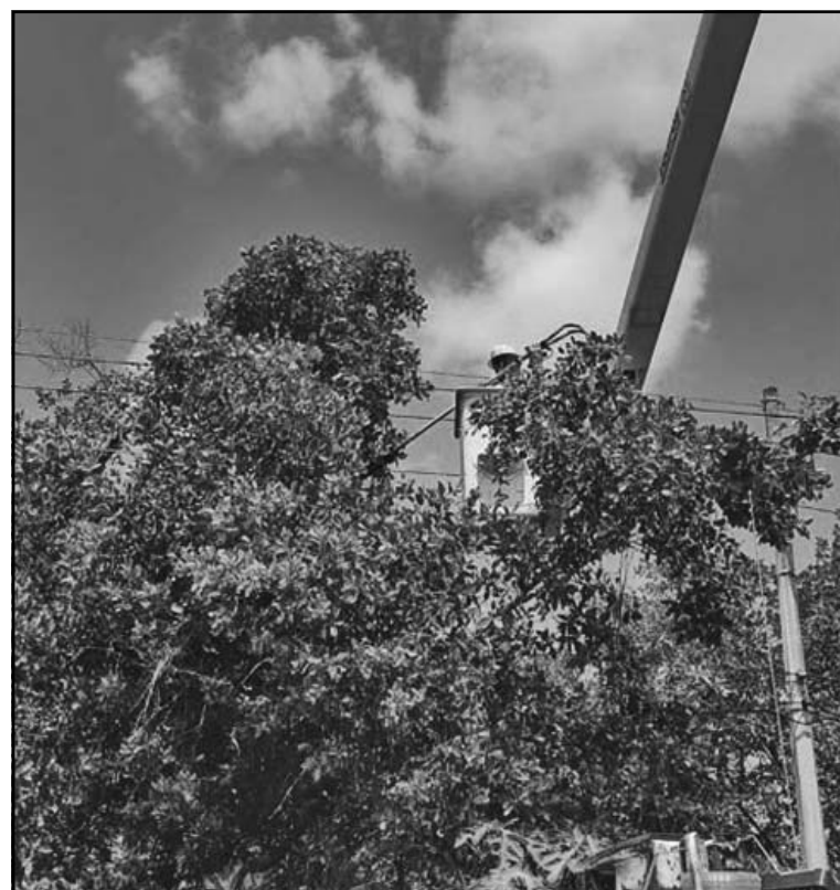
Un trabajador hace reparaciones desde lo alto, entre la vegetación.
