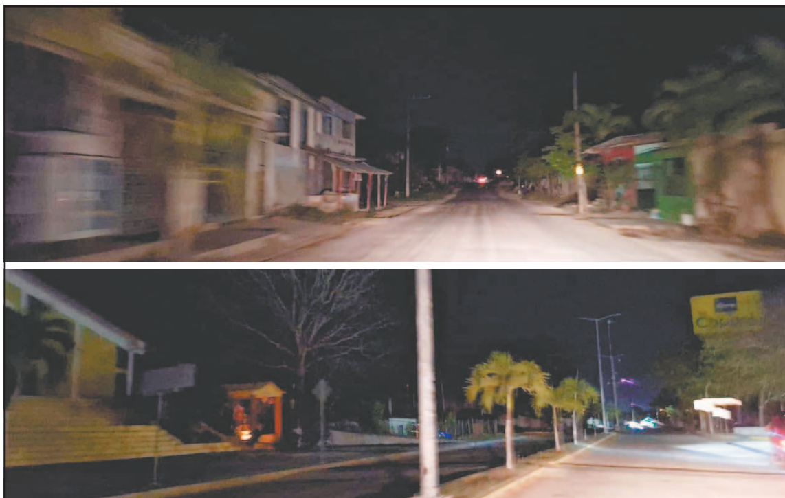
Al parecer una avería en un transformador es la causante de la falta de suministro. (Fotos POR ESTO!)
