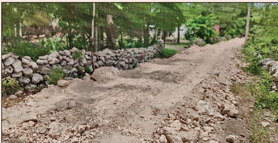
Los montones de escombros dificultan el tránsito, sobre todo para las personas de la tercera edad.
