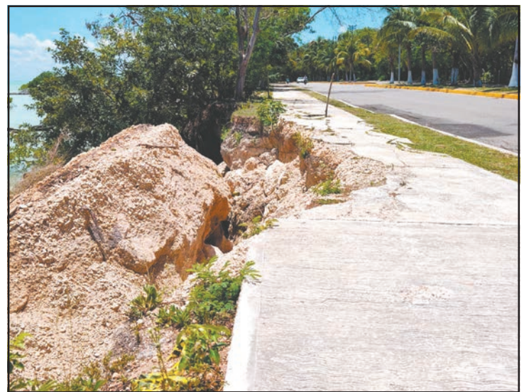
El oleaje sigue impactando los bloques de concreto. (Fernando Olvera)
