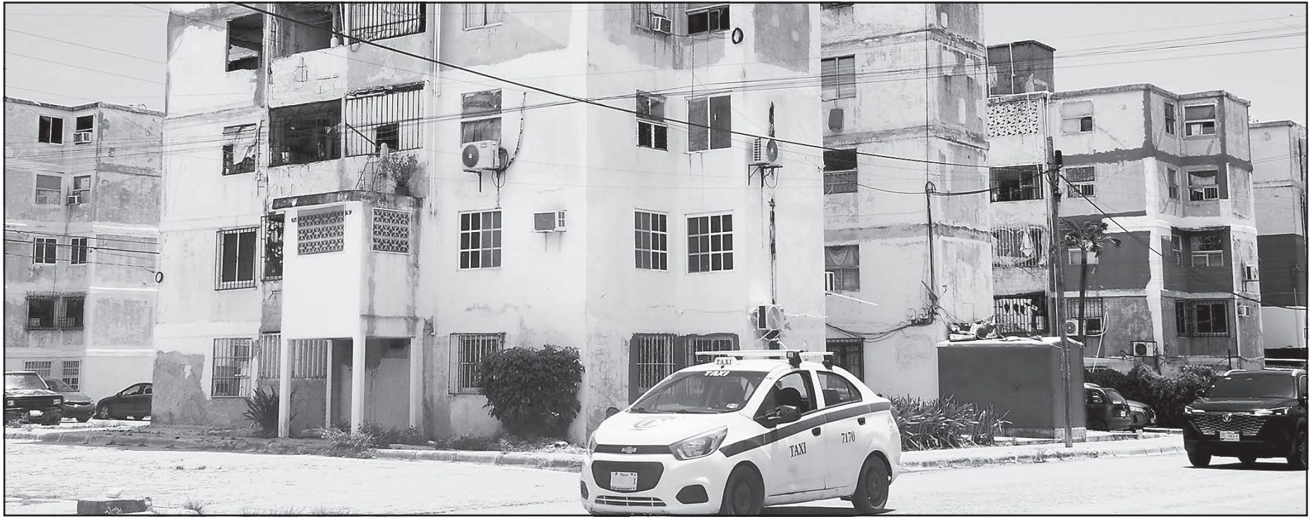
Vecinos de diversos fraccionamientos destacaron que las filtraciones, grietas y fugas de agua son problemas recurrentes, especialmente cuando llueve. (Liza Vera)
