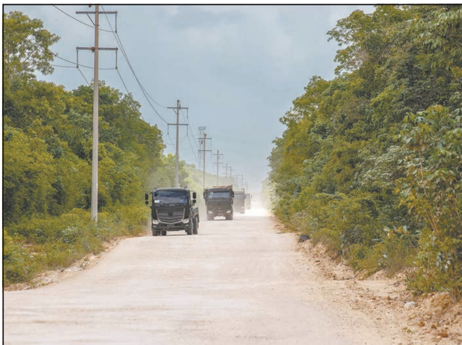
En Cancún tienen como meta concluir las obras en diciembre. (Fotos Rodolfo Flores)
