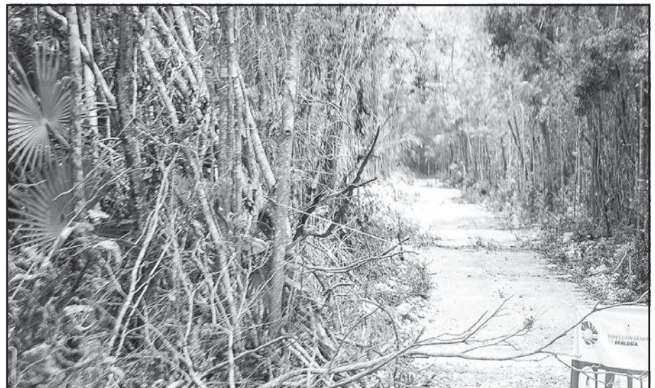
Se suspendieron los trabajos debido a que no se cuenta con los permisos a la vista.
