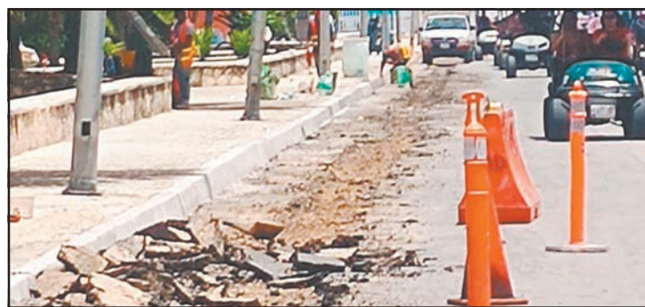
Ayer iniciaron obras de pavimentación sobre el malecón. (O. López)
