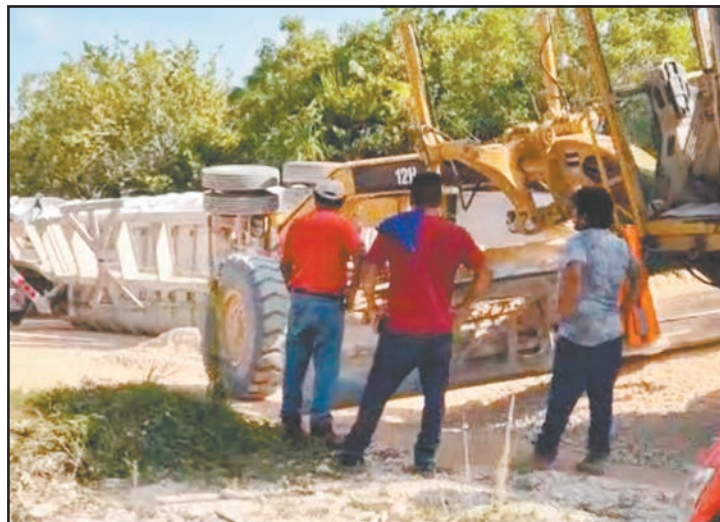
La carga quedó esparcida dentro del frente de obra. (L. Hernández)
