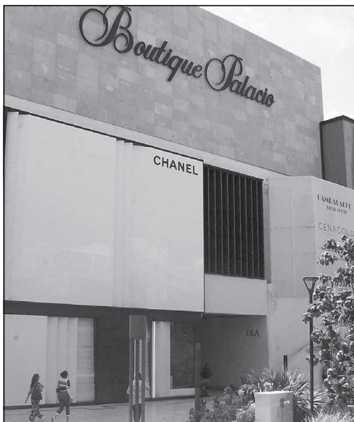
La propuesta prevé la demolición del Palacio de Hierro. (Liza Vera)
