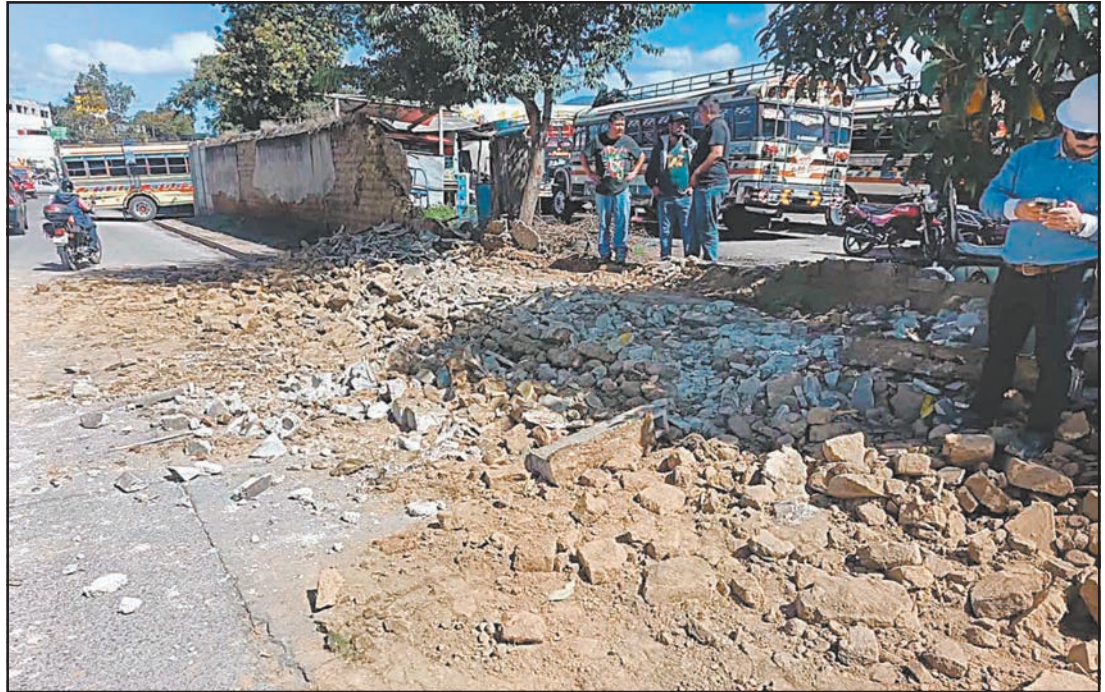
En la entidad afectada se agrietaron y se desprendieron piedras en algunos edificios. (Agencias)
