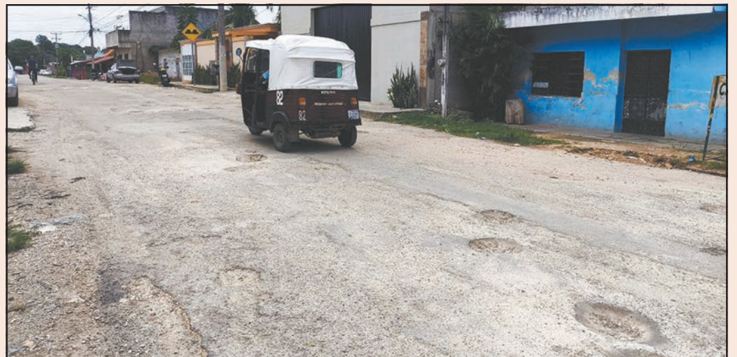
Habitantes revelaron que en toda la ciudad se observan hoyancos de diversos tamaños. (Lusio Kauil)
