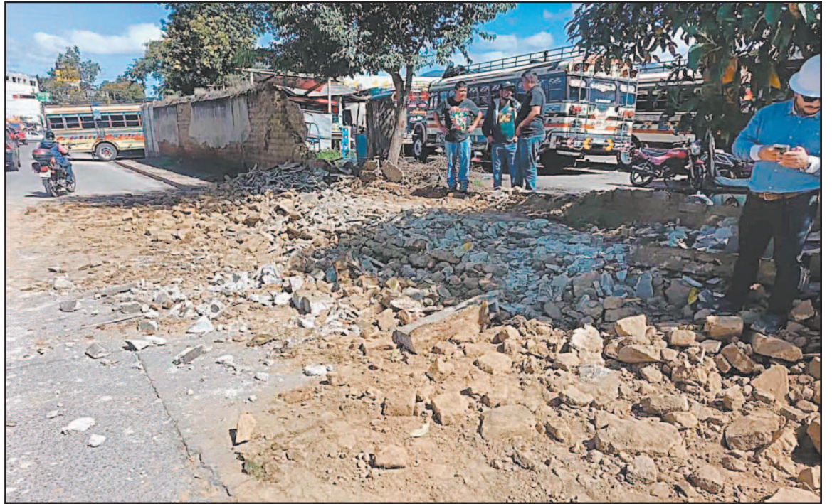
En la entidad afectada se agrietaron y se desprendieron piedras en algunos edificios. (Agencias)
