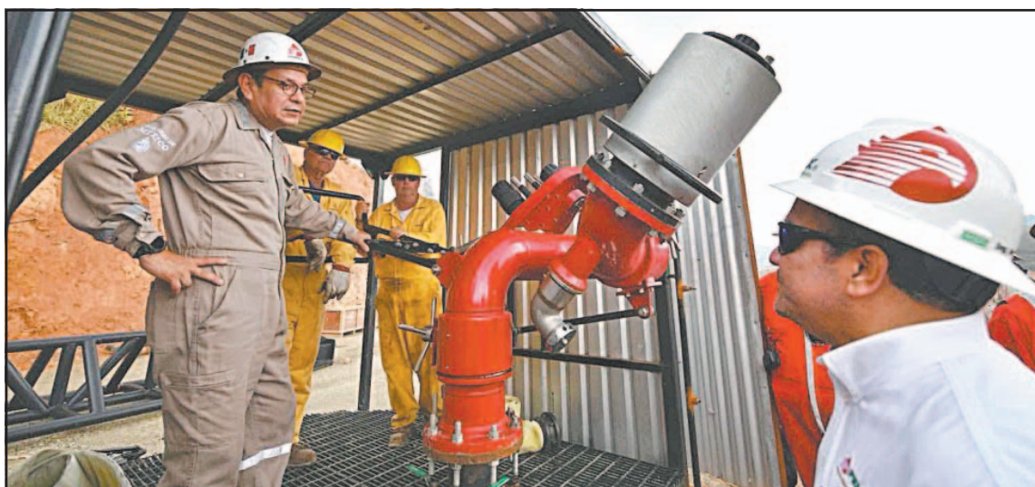
Se instaló un nuevo sistema de válvulas y tuberías para detener el flujo de emanaciones. (Agencias)
