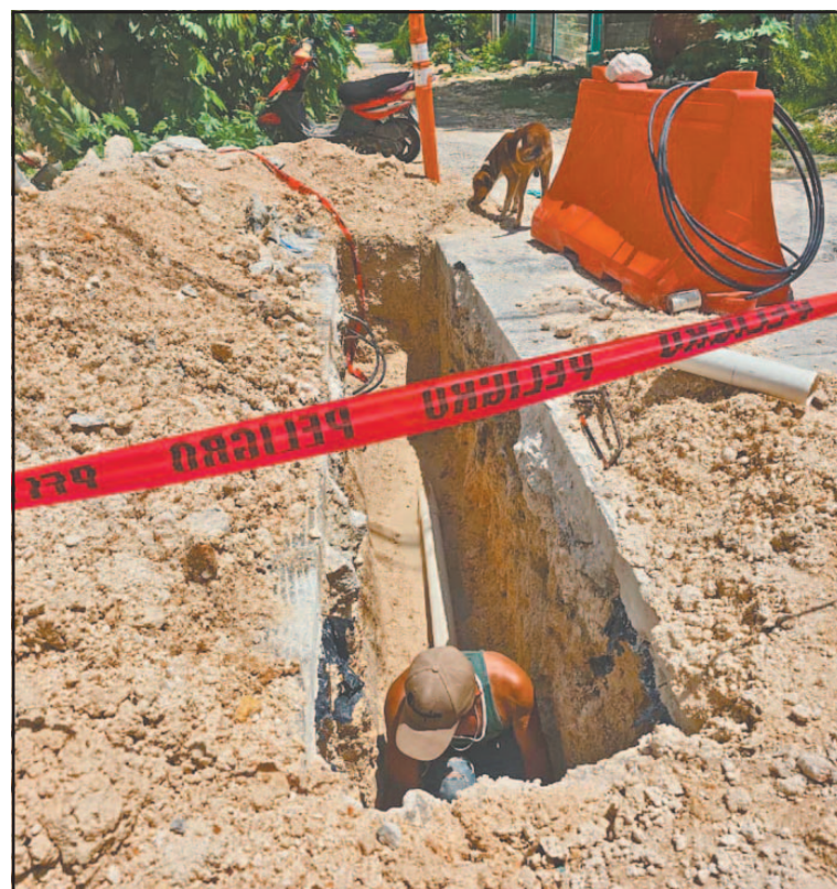
Trabajadores del Smapac reparan tuberías nuevas. (Alejandro Pech)
