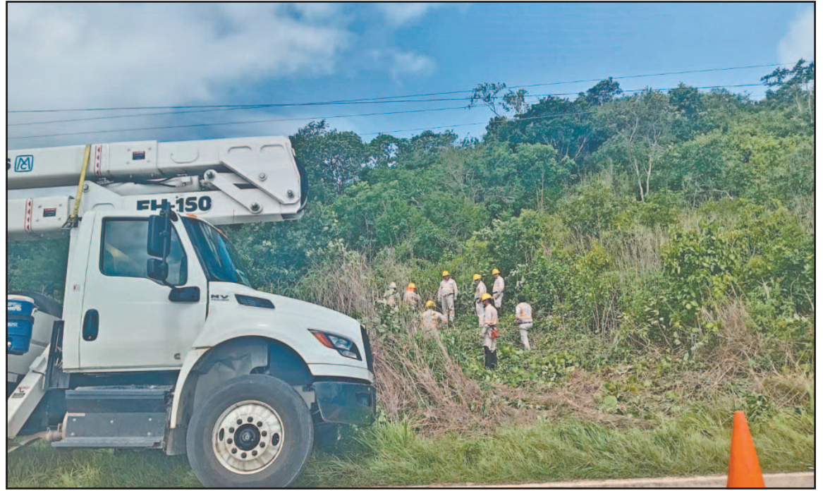
Los trabajadores abrirán una brecha de 10 kilómetros para colocar postes y cableado. (Mauriel Koh)
