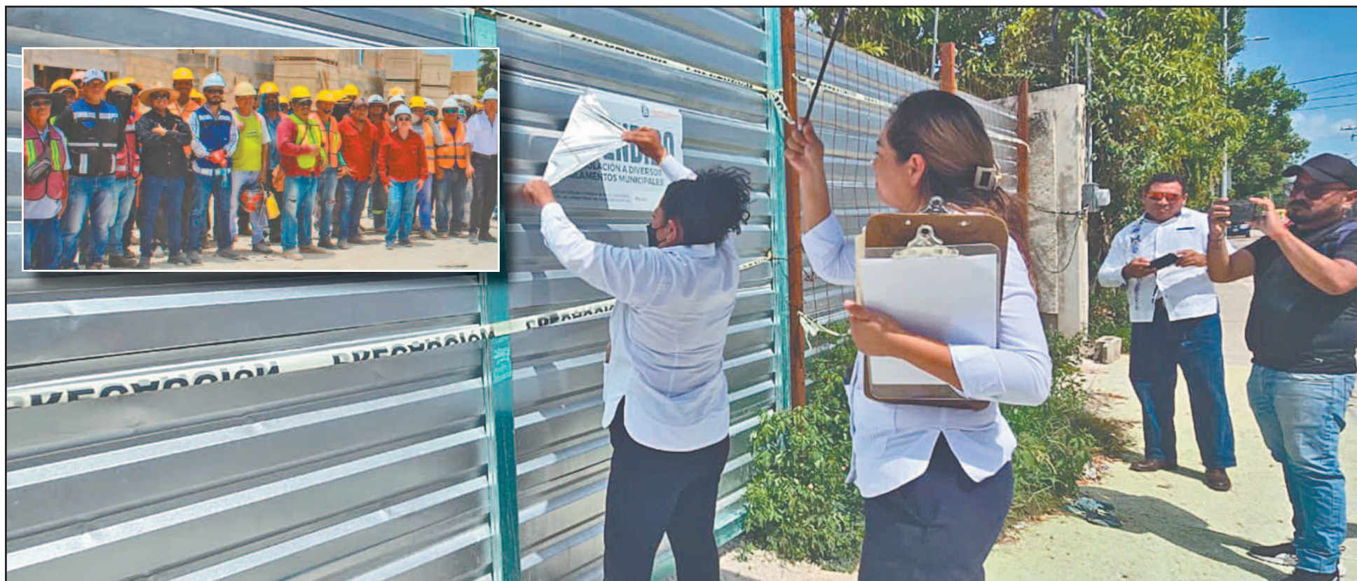
La suspensión afectó a los obreros y contratistas durante tres meses, además se realiza un estudio para conocer el impacto económico por daños y robos de materiales.
