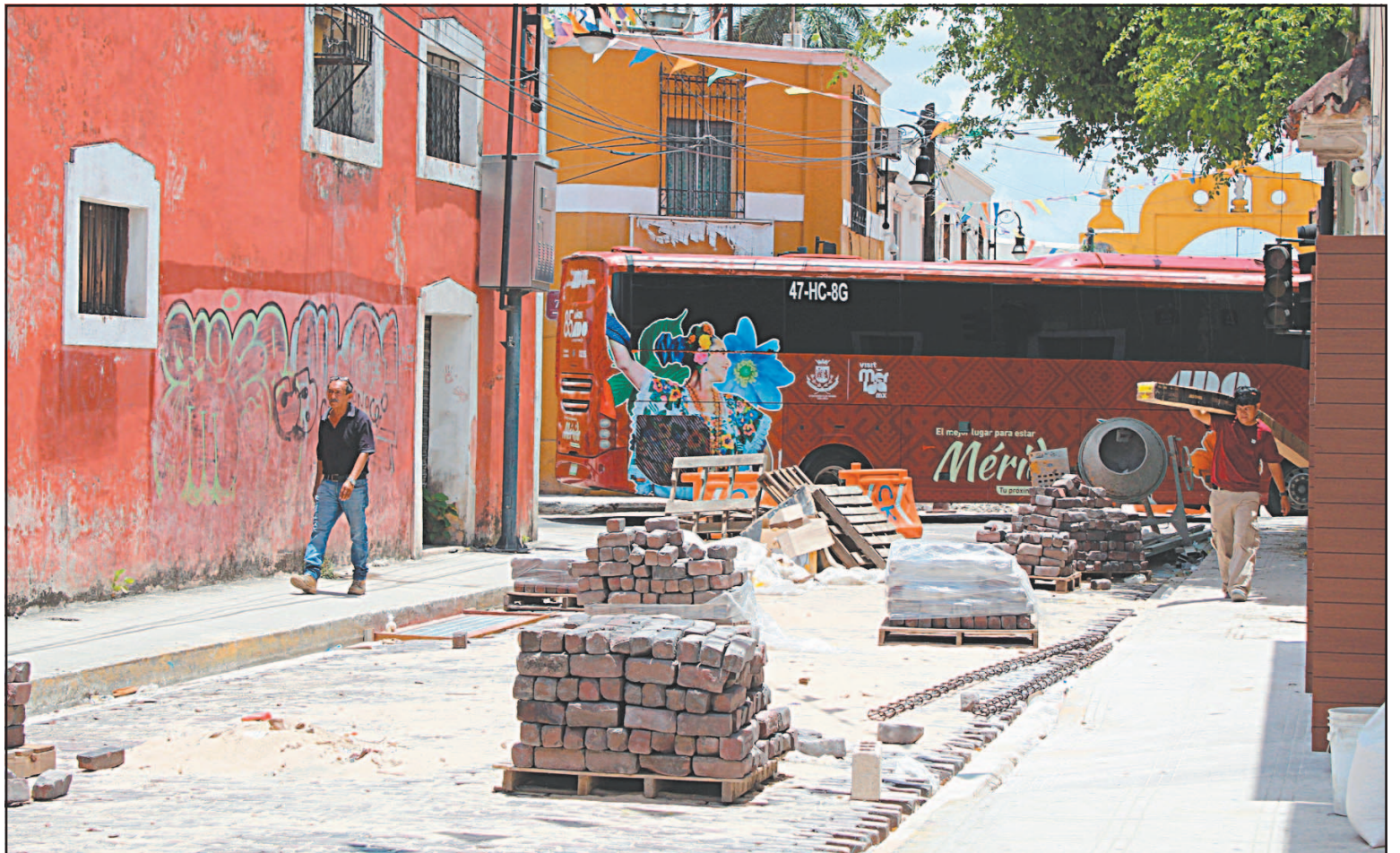
Autoridades mantienen el calendario previsto para concluir a fines de agosto la instalación de adoquines de San Juan a la Ermita . (POR ESTO!)
