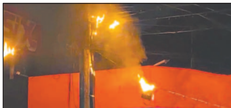
Las llamas afectaron las líneas eléctricas, de Internet y telefonía.
