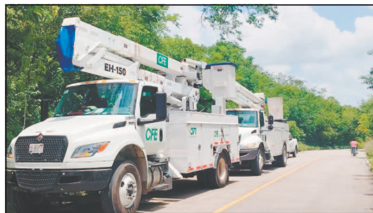
Una brigada de la CFE trabajó en el tramo Laguna Kaná-Yoactún. (J. Xiu)
