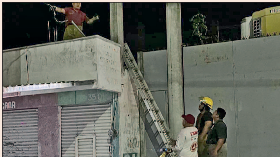
Trabajaron durante una hora para restablecer el suministro eléctrico en las viviendas. (Especial)
