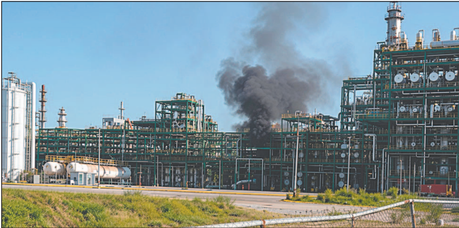
El pasado 17 de marzo se registró un evento asociado a lluvias que provocaron la ignición de aguas aceitosas en el sitio. (Agencias)
