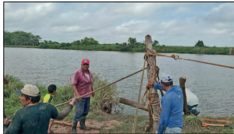
Advierten que hay más infraestructura en riesgo de caer. (POR ESTO!)
