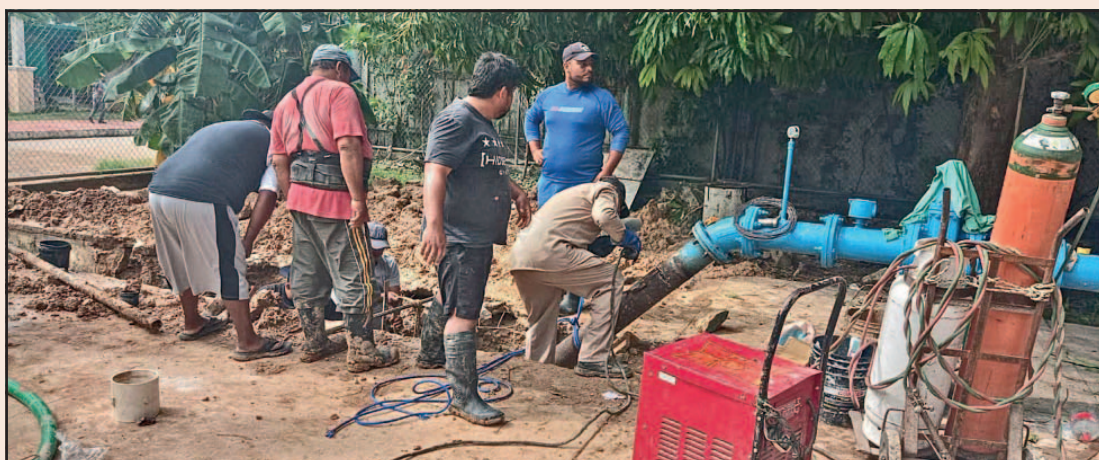
La dependencia publicó en redes que la reparación ‘presenta importantes avances’. (POR ESTO!)
