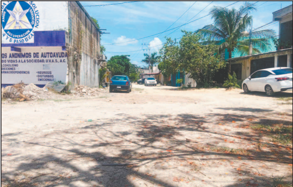
Automovilistas reportaron hoyancos y grietas en puntos de la ciudad. (Fotos POR ESTO!)
