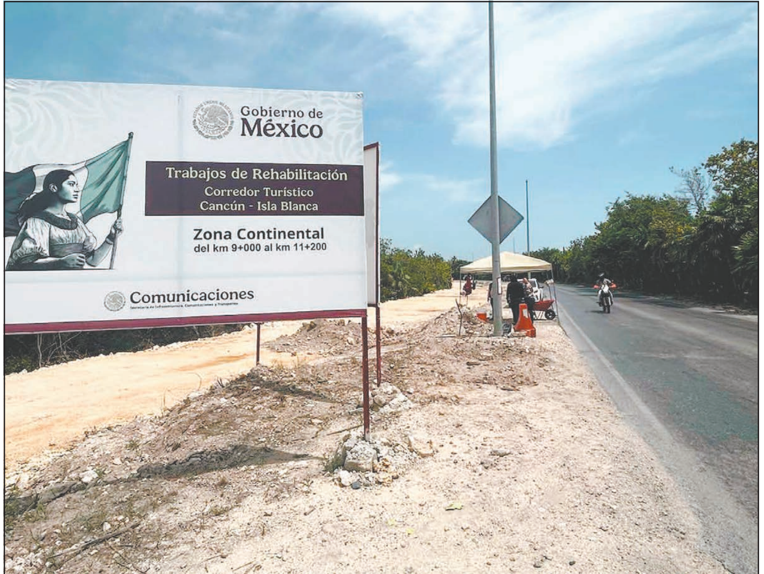
Actualmente el proyecto está en fase de nivelación de terracerías e identificación de líneas de energía eléctrica, agua potable y otros servicios.
