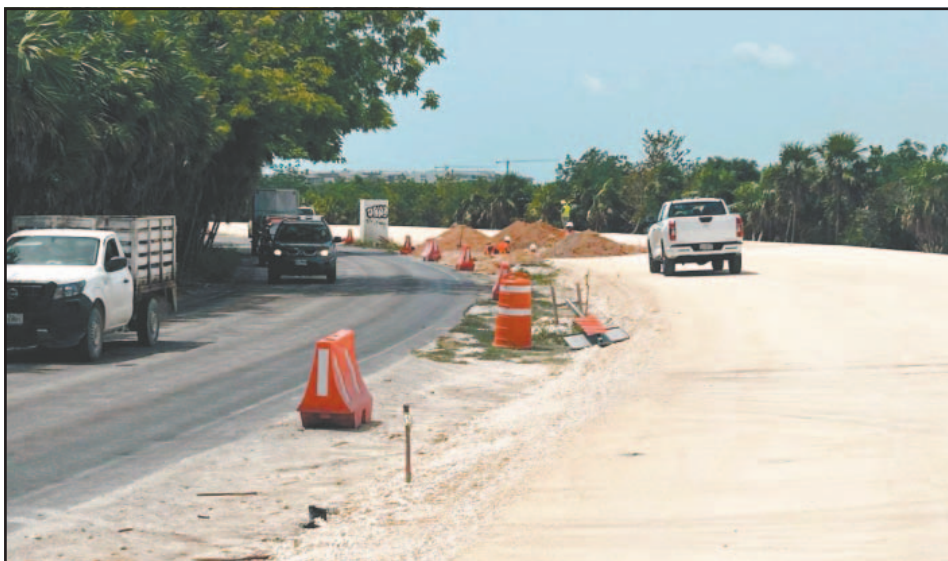
Son dos kilómetros intervenidos lo que afectan el tránsito diario de los automovilistas.
