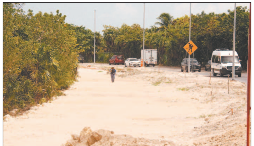
Este año se ejecutarán la primera y la segunda etapa de los trabajos. (Fotos L. Vera)
