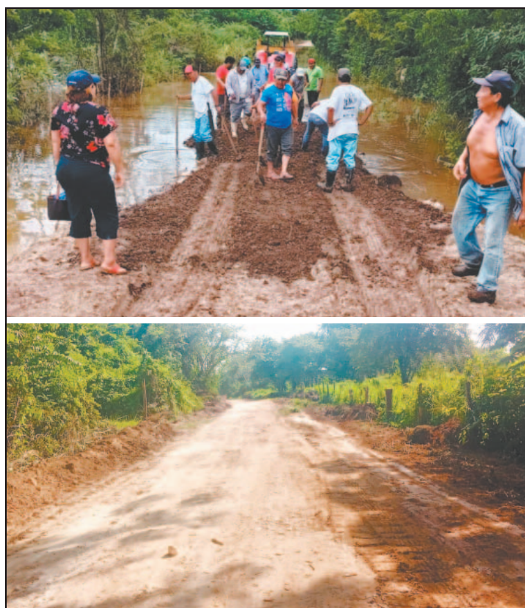
Prevén agricultores que la obra quede lista en noviembre (Fotos E. Cauich)
