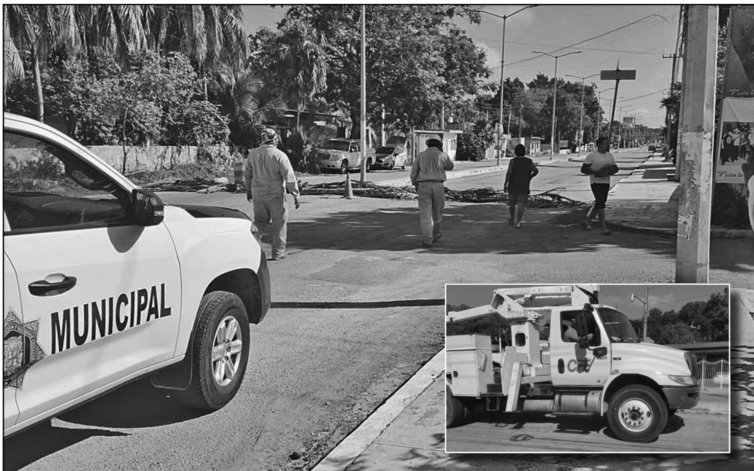
Mientras una cuadrilla cambiaba el transformador, otros empleados de la paraestatal reemplazaban líneas en mal estado. (Erik Caamal)
