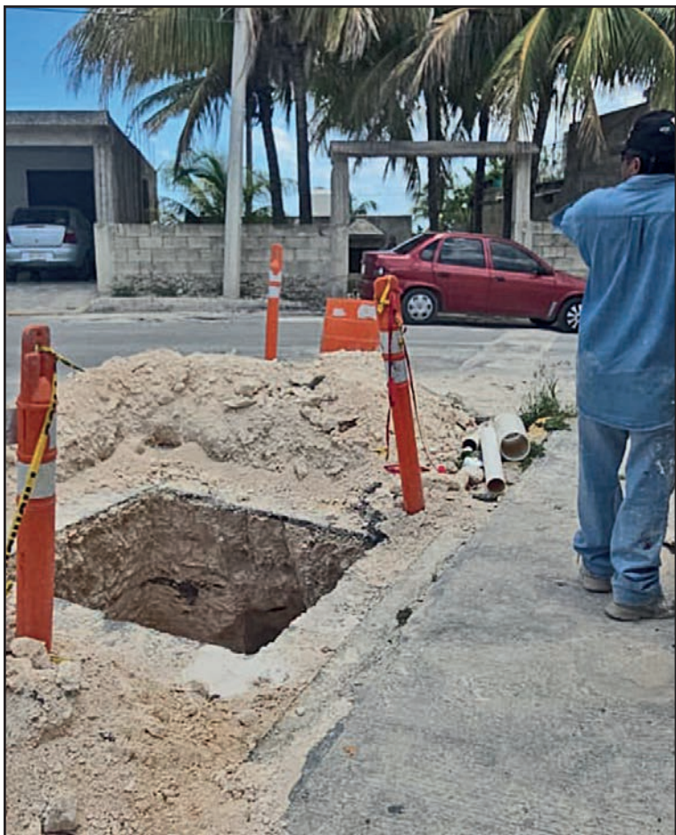
La calle Tumbo permanece con cierres parciales por las reparaciones.
