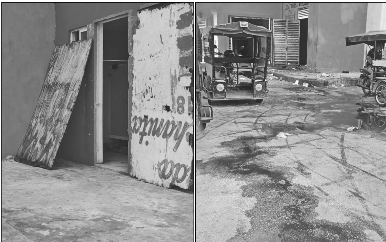
Temen que el foco de infección desate contagios de enfermedades, sobre todo por encontrarse cerca de puestos de comida. (E. Caamal)
