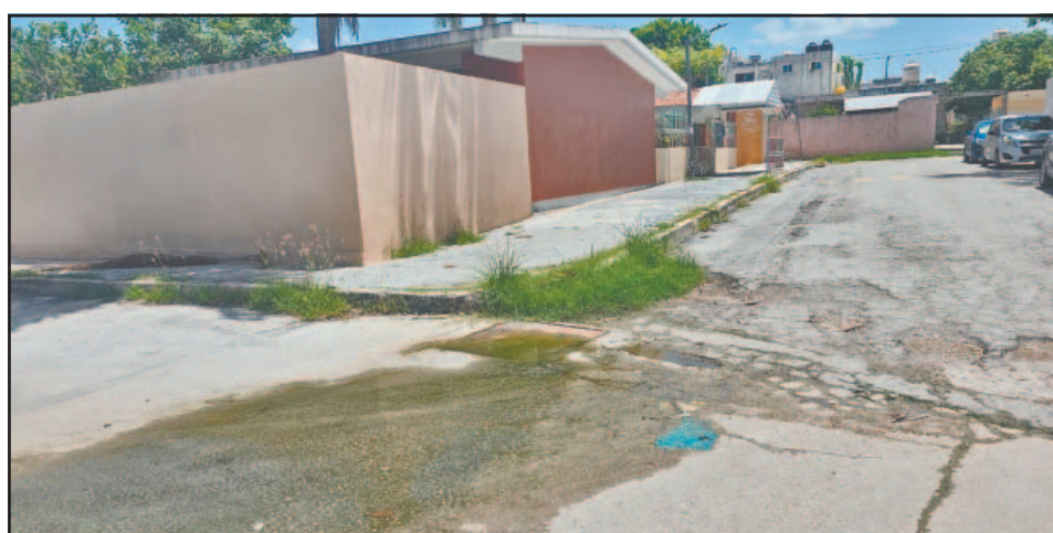
La unidad carece también de luminarias y parques, las banquetas son pocas y en mal estado.
