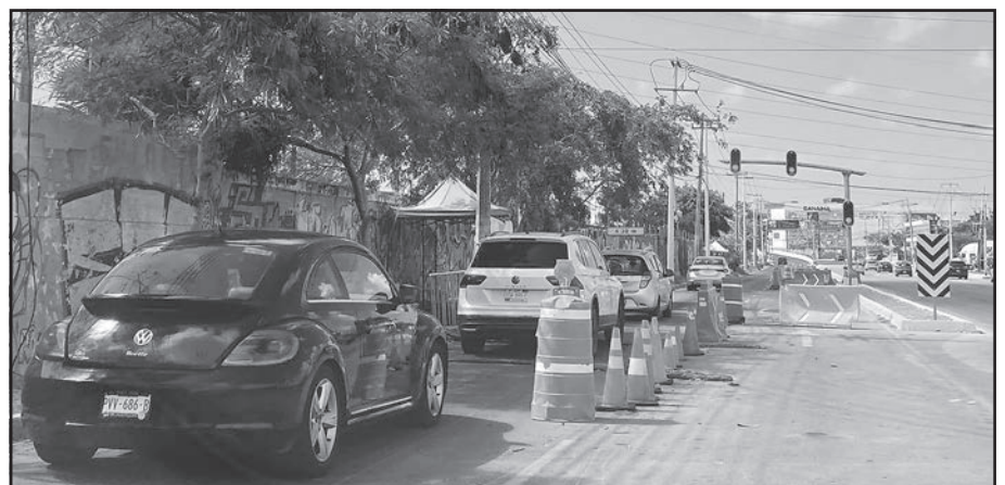
Criticaron que el acceso a la nueva infraestructura se limita con varios trafitambos.
