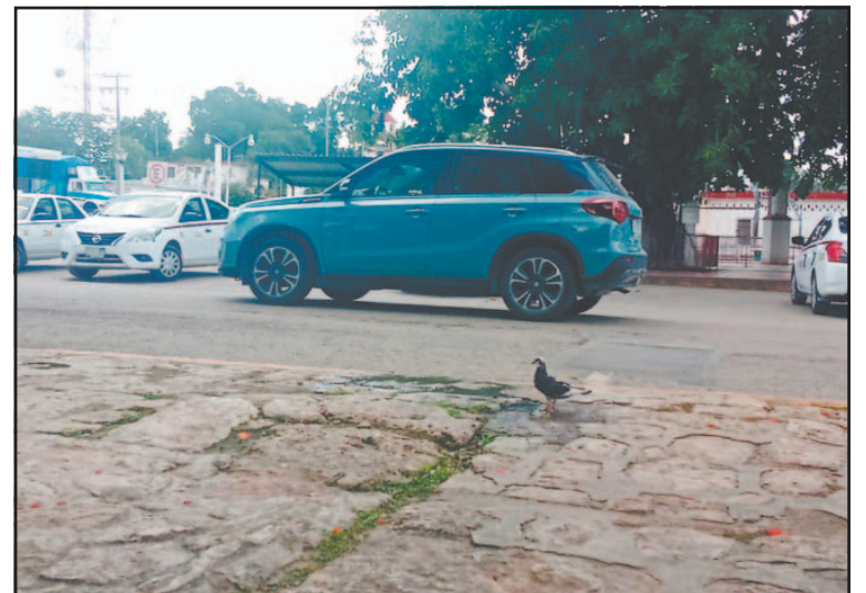
Taxistas dijeron que son dos sitios en los que hay pérdida de líquido.
