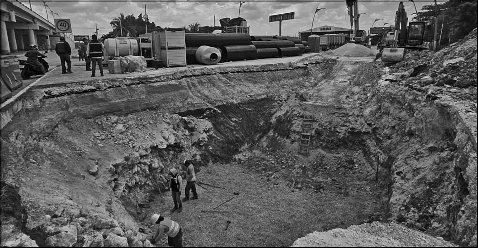
Ingenieros enfrentan las condiciones del suelo y preparan un cruce subterráneo que permitirá completar la conexión hidráulica. (A. Pech)
