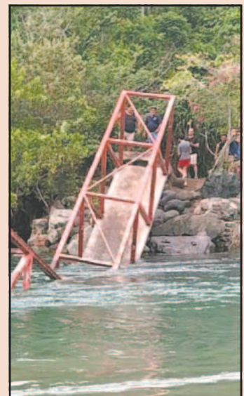
El desplome de la estructura ocurrió en La Boquita . (Agencias)
