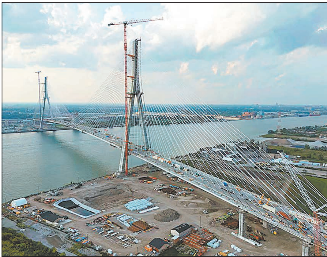
La vía de 6 carriles fue construida por Canadá a un costo de 4 millones 531 mil dólares. (Agencias)
