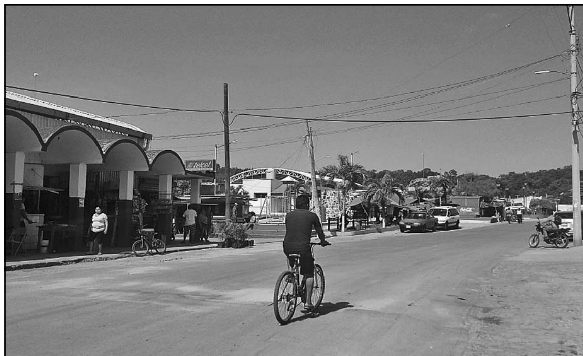
Los moradores piden que se cambie todo el tendido eléctrico para terminar con el problema. (M. Koh)
