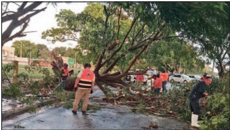
Brigadas trabajan en el retiro de estructuras dañadas. (Especial)
