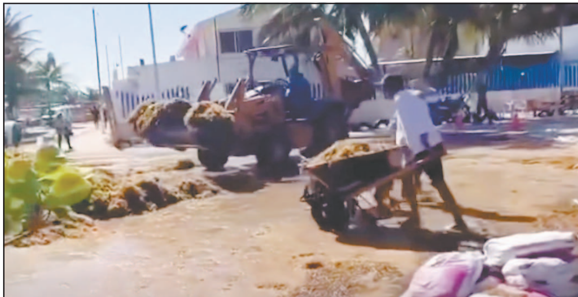
Más de 200 ciudadanos colaboraron en el retiro de la macroalga, apoyados con carretillas y maquinaria.
