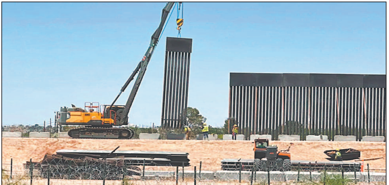
Una parte preliminar estará terminada “para esta misma fecha del próximo año”, dijo el secretario de Seguridad Nacional. (Agencias)
