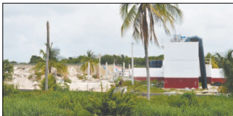
La ampliación de la planta San Miguelito aún no concluye. (A. Blanco)
