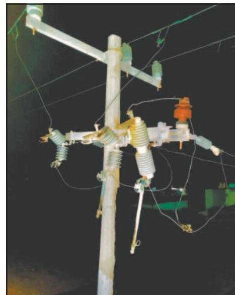
La carencia del servicio es originada por el desprendimiento de varias cuchillas.
