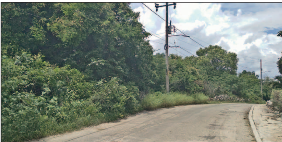
Las ramas podrían afectar el alumbrado público y el cableado de la CFE. (Mauriel K.)
