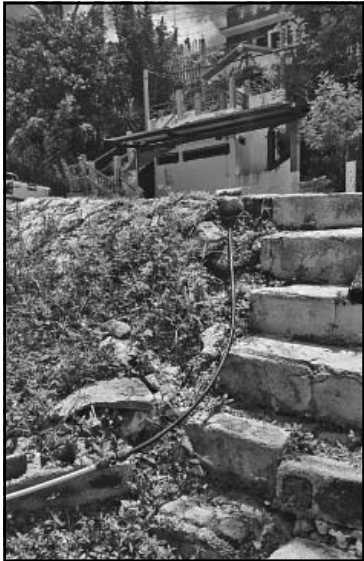
En algunos sectores el agua no llega a los tinacos de las viviendas.
