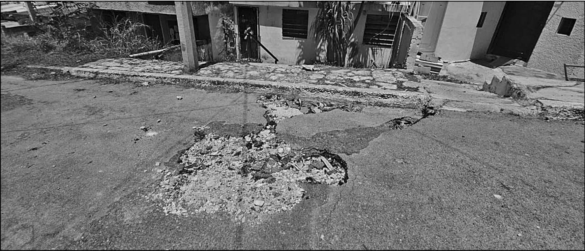
Los habitantes acusan que las deficiencias en el suministro persisten mientras los inspectores municipales acuden a aplicar multas, pero no a resolver los problemas de infraestructura.
