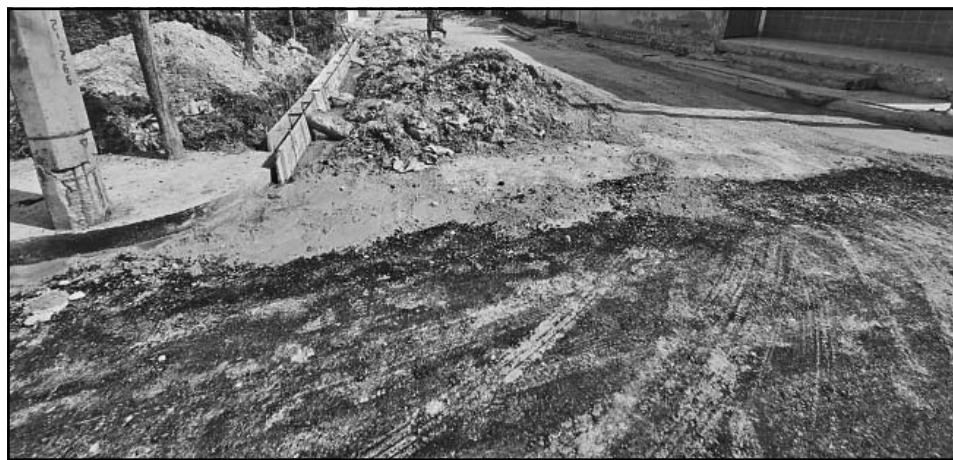
Avanzan en Siete de Noviembre y Roberto Ayala, con construcción de aceras y cunetas.
