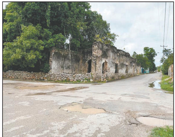
El deterioro de las vialidades prevalece en 15 colonias. (René Uicab)
