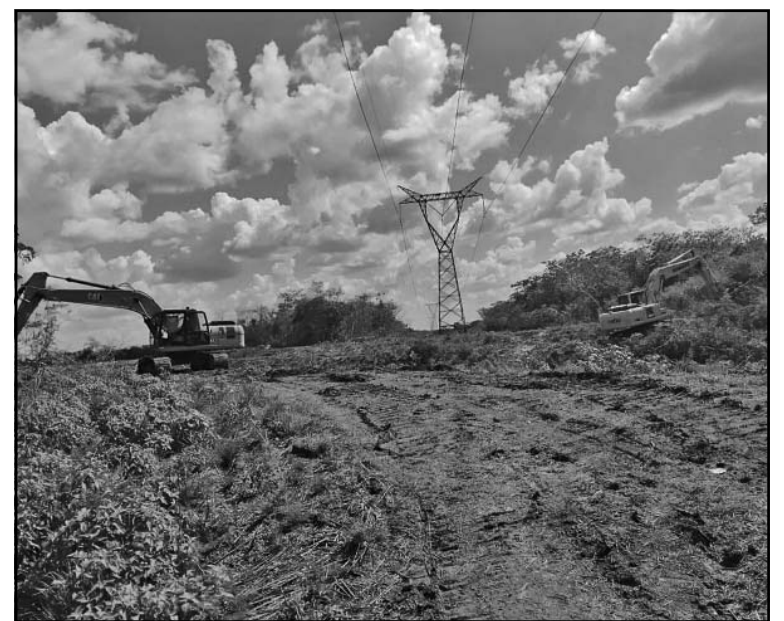
La obra de rehabilitación del dren reducirá el riesgo de inundaciones.
