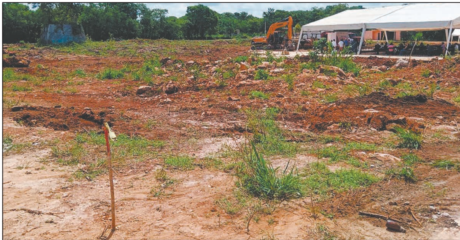
El predio del nosocomio está en la prolongación de la calle Miguel Hidalgo y Chilam Balam, 300 metros detrás de Bachilleres. (Lusio Kauil)
