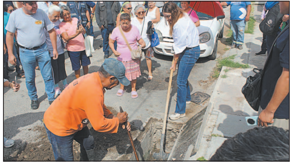
Cecilia Patrón supervisó los trabajos realizados durante el mega operativo. (POR ESTO!)
