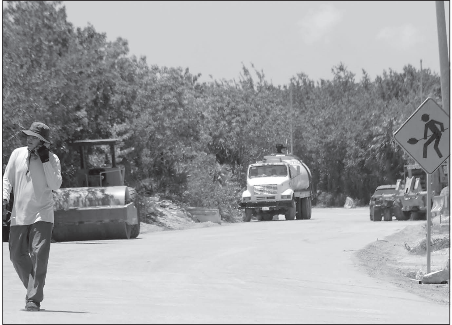
La carretera abarca del kilómetro 7 al 11.2 y es impulsada por el Gobierno federal, con una inversión de 380 millones 962 mil 644 pesos.
