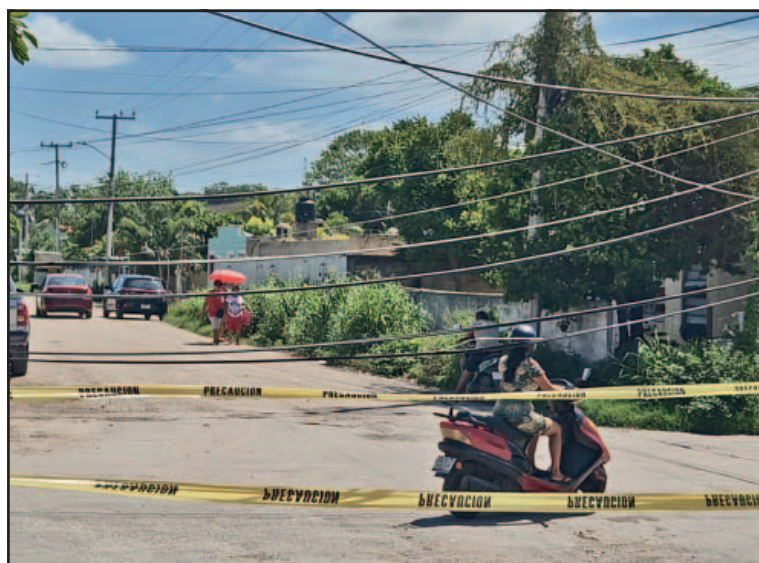
Los cables cuelgan peligrosamente a muy baja altura. (Jorge May)
