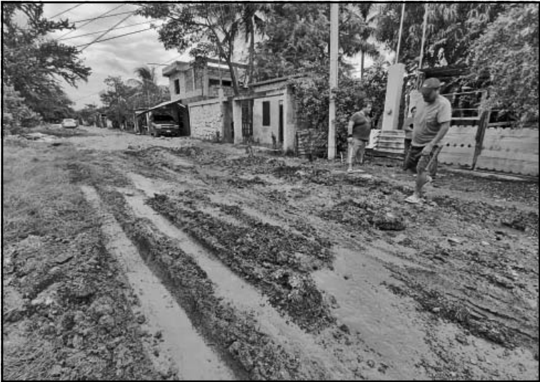
Habitantes de la Ría denuncian lodo, inundaciones y riesgos para peatones.
