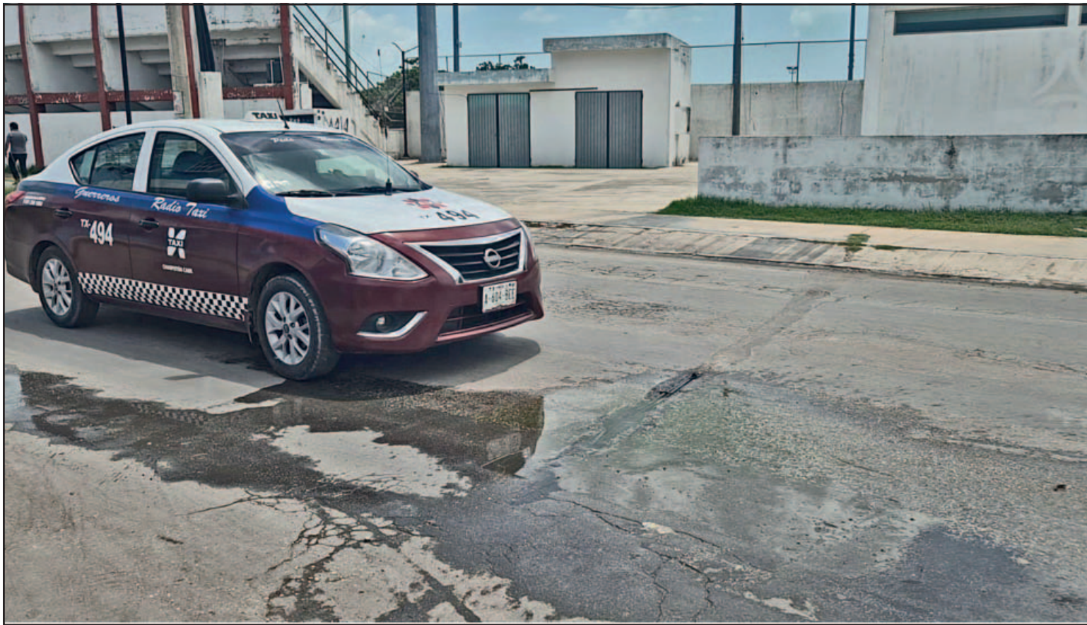
Se ha formado verdín sobre la cinta asfáltica ante el constante desperdicio del líquido y torna resbaloso el pavimento. (Jorge May Sosa)
