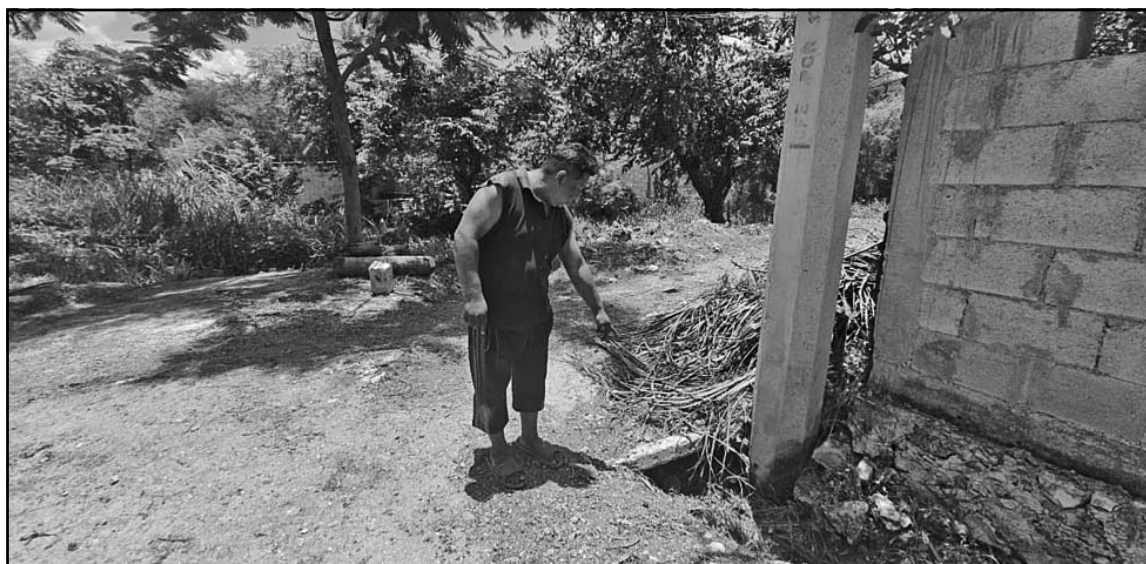
Las condiciones de las vialidades impiden el acceso de ambulancias y otros vehículos de emergencia.
